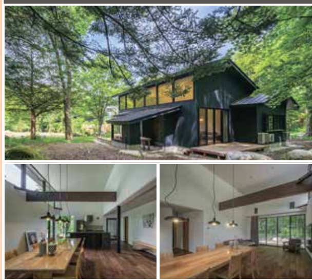
豊山荘新築工事 ◆南木曽町
