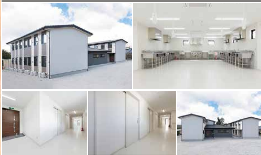
清和陶器株式会社様 第二清和寮新築工事 ◆多治見市
