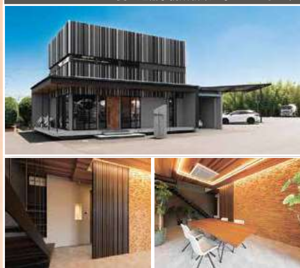
菱一運輸事務所新築工事 ◆いなべ市
