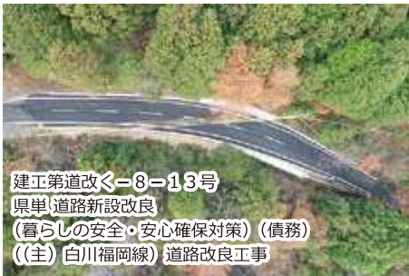
白川福岡線道路改良工事 ◆中津川市
