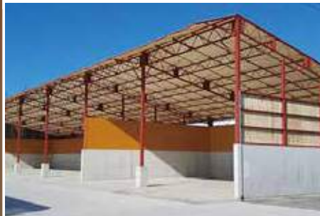
(株)うし和牧場様牛舎増築工事 ◆垂井町
