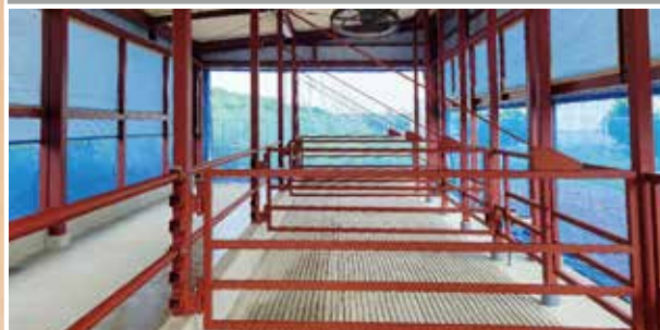
岐阜大学乾乳・育成用牛舎新営その他工事
